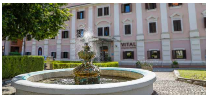
V Termah Dolenjske Toplice trenutno obnavljamo hotel Vital, najstarejši hotel zdravilišča. Po prenovi, ki bo zaključena v letu 2027, bo znova sijal – s spoštovanjem do tradicije ter sodobnim udobjem za varno in prijetno bivanje.
