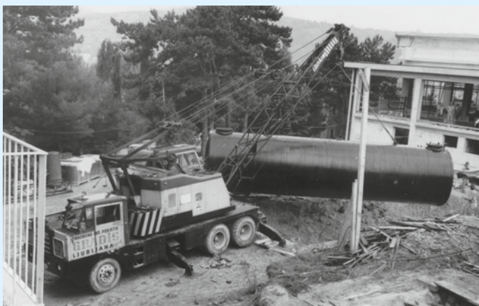
Gradnja pokritega bazena in Hotela Svoboda.
